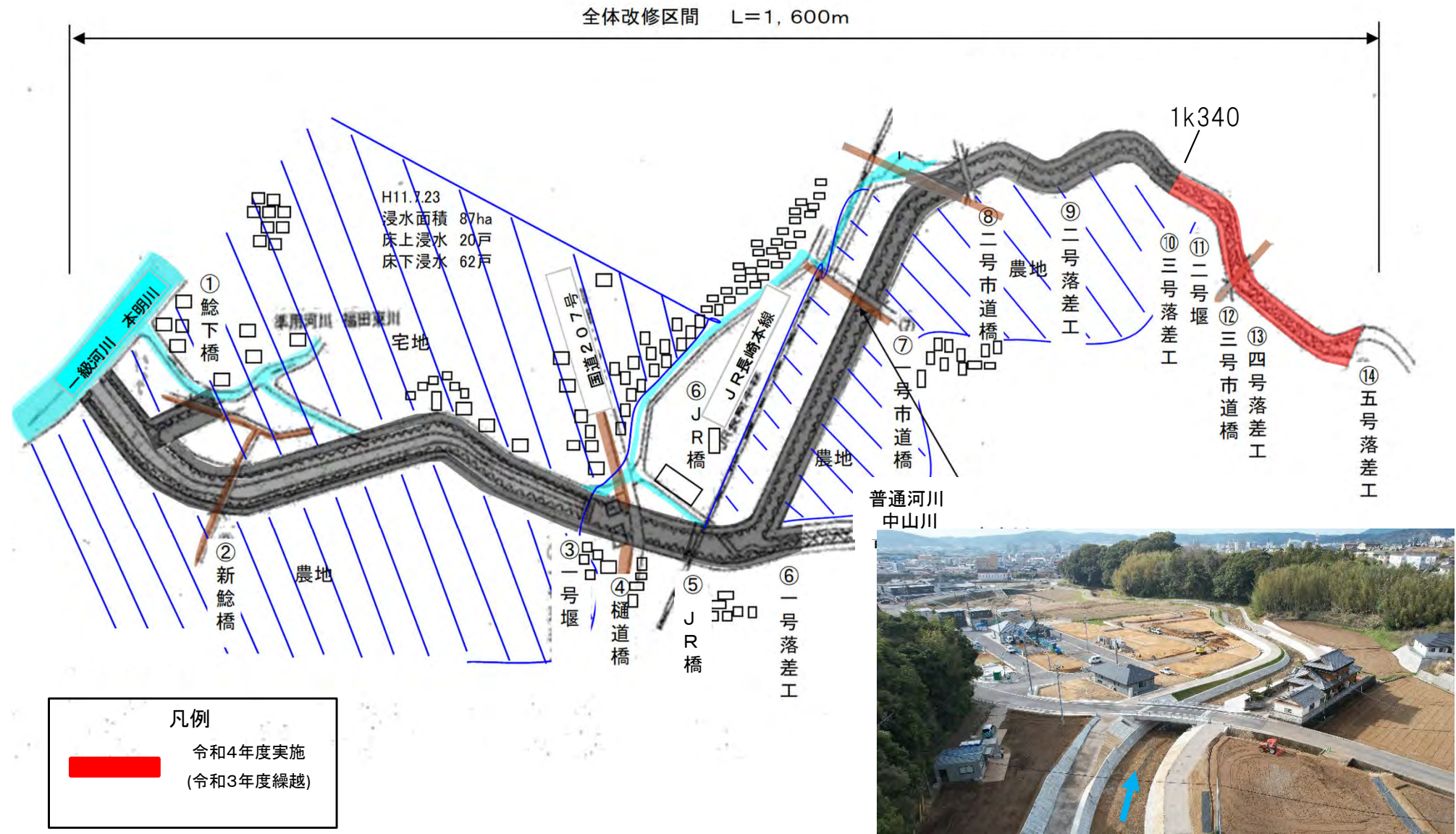
施工状況(1k340～終点)
