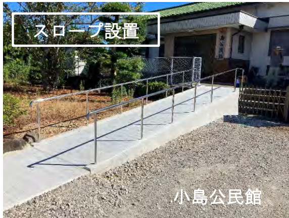
令和5年度改修
