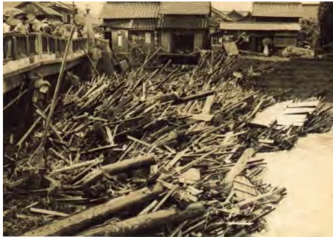
流木の堆積状況(S32.7諫早大水害)
