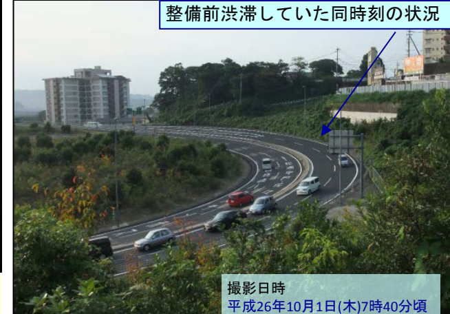
整備後の状況 (写真②)
