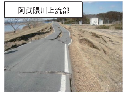
地震による堤防の被災状況
