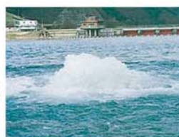
曝気循環設備 の運転状況
