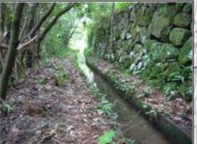
■ 大渡野用水 戦国時代に作られた用水路だが、現在はコンクリート製U字溝となっている。
