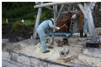
地中の管は 湯垢を削り落す 配管は叩いて落す
