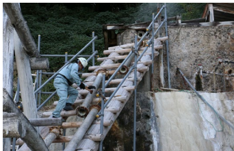
地中の管は 湯垢を削り落す 配管は叩いて落す
