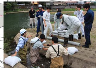
【土のう積み訓練の状況】
