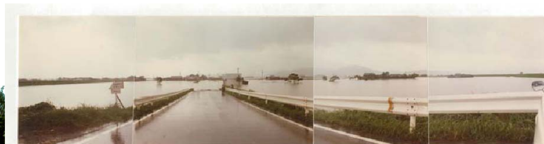
0k800付近右岸の堤内浸水状況(新地地区:24日10時頃)
