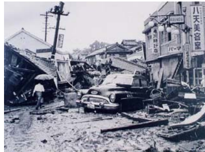
昭和32年7月洪水(八天町付近)
