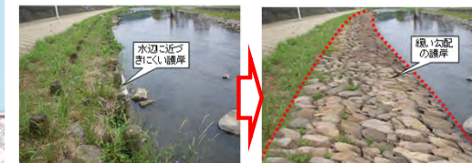
かわまちづくり(管理用通路の整備)
