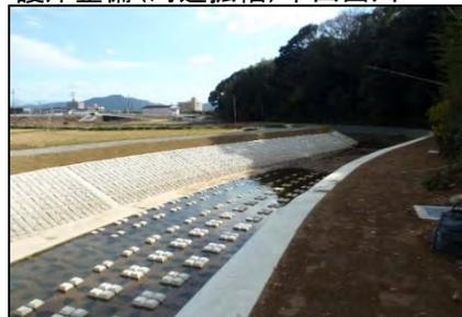
治山施設の整備による土砂流出抑制
