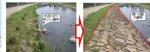
かわまちづくり(管理用通路の整備)
