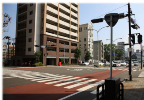
国道34号 万才地区電線共同溝 0.08km (道路延長0.04km)
