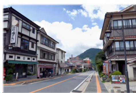
国道57号 雲仙地区(1)電線共同溝 1.40 km(道路延長0.87km)
