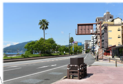
国道57号 小浜地区電線共同溝 0.58km (道路延長0.58km)
