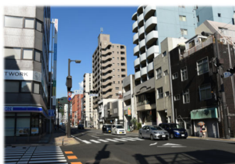
国道34号 桜町地区電線共同溝 1.12km (道路延長0.56km)
