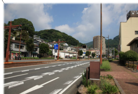
国道34号 中川地区電線共同溝 0.56km (道路延長0.33km)
