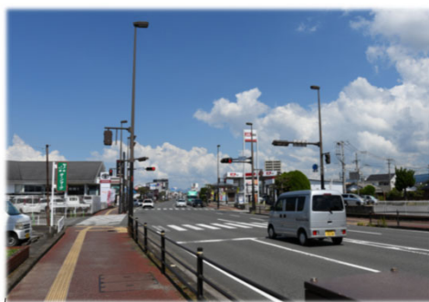
国道34号 桜馬場地区電線共同溝 4.00 km(道路延長2.00km)
