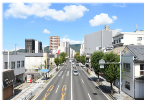
国道35号 藤原地区電線共同溝 2.76km (道路延長1.55km)
