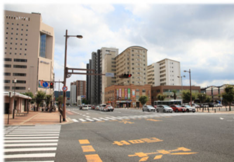
国道35号 瀬見地区電線共同溝 1.04km (道路延長0.35km)
