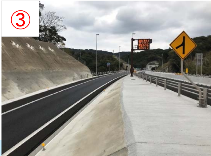
【起点側を望む】
