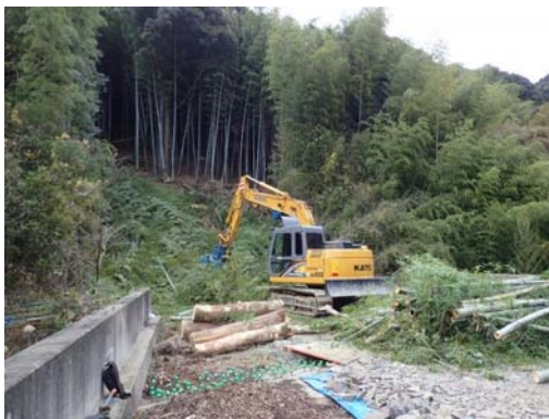
トンネル入口部の伐採
