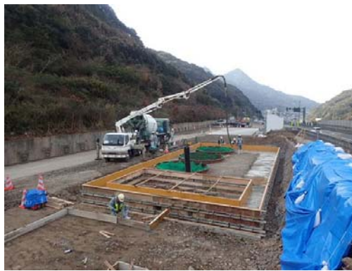
トンネル工事に必要な設備の基礎部分構築
