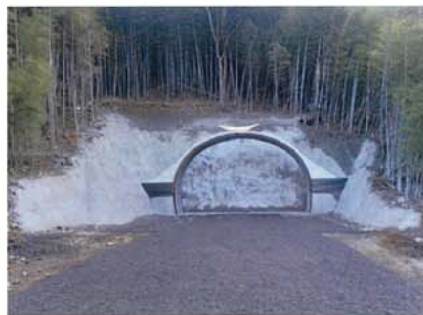
トンネル掘削がいよいよ始まります (H30年3月1日)
