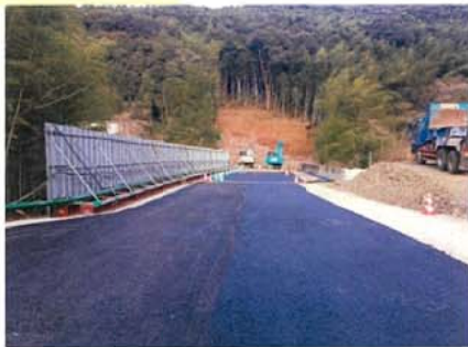
工事用道路をアスファルト舗装(粉塵対策) (H30年2月26日)
