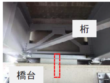
写真-5 アンカーバーのイメージ
