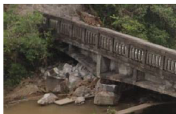
写真-2 平田・小柳線 田中橋
