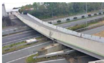
写真-1 県道小川嘉島線 府領第一橋
