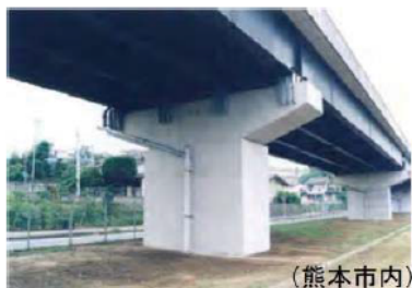
写真-3 国道3号 跨線部 (熊本市内)
