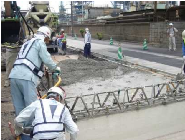
簡易フィニッシャによる施工事例
