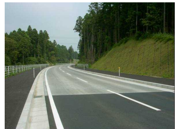
県道成田小見川鹿島港線 千葉県香取市※3 (ポーラスコンクリート舗装※4)
