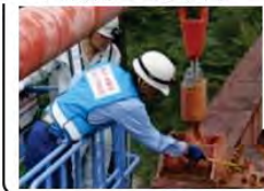
ケーブルの力 バー部の腐食
