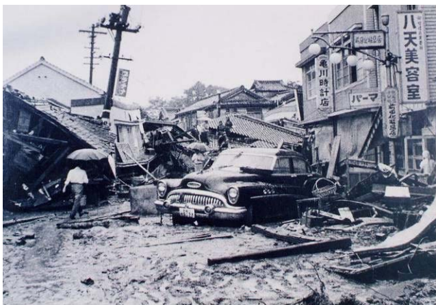
▲ 八天町の家屋倒壊の状況
