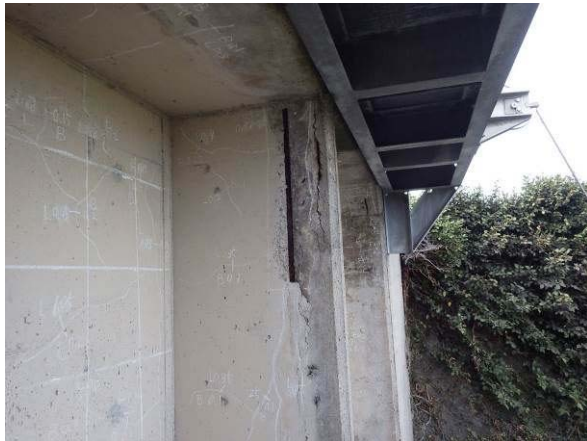
写真2-1-4 長田第5樋門の鉄筋露出
