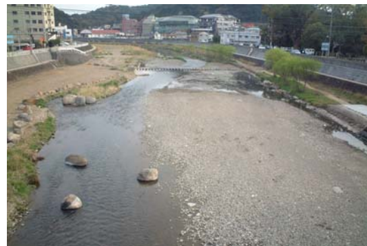
堆積土砂撤去後
