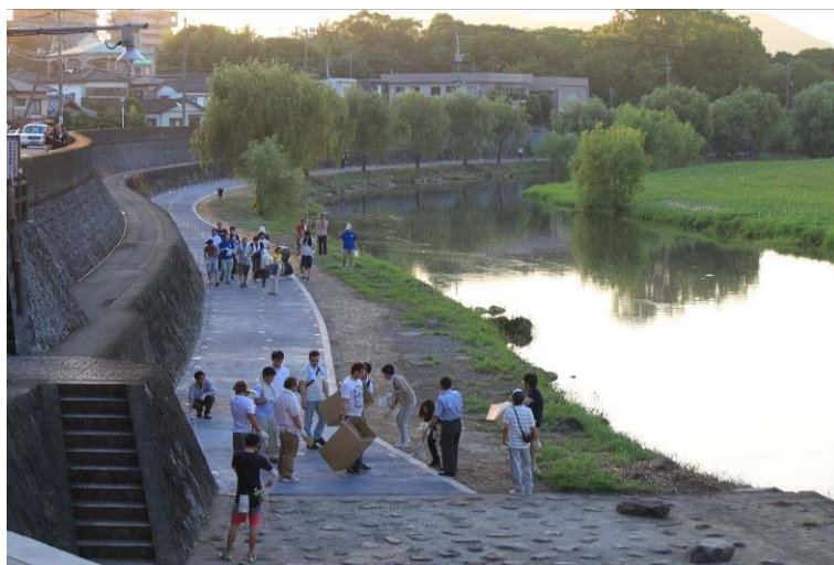
写真5-1-7 天満・永昌地区の管理用通路
