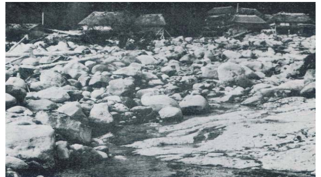
▲ 湯野尾町中島付近の流失水田
