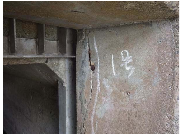
写真2-1-3 長田第1樋門のクラック
