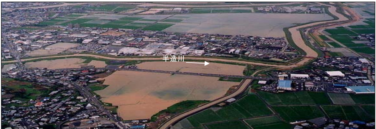
▲ 半造川周辺の浸水状況
