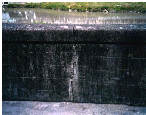
特殊堤における亀裂状況
