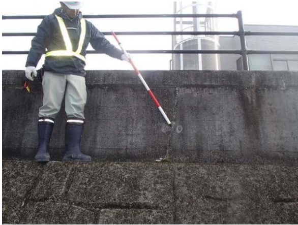
写真2-1-2 特殊堤の老朽化状況
