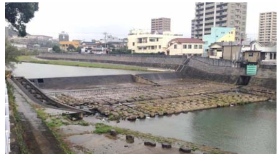
写真1-3-1 公園堰(本明川 5k000 付近)
