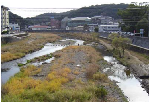
堆積土砂撤去前
