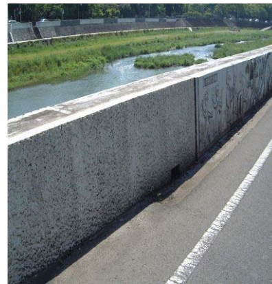
ひび割れ補強後の状況
