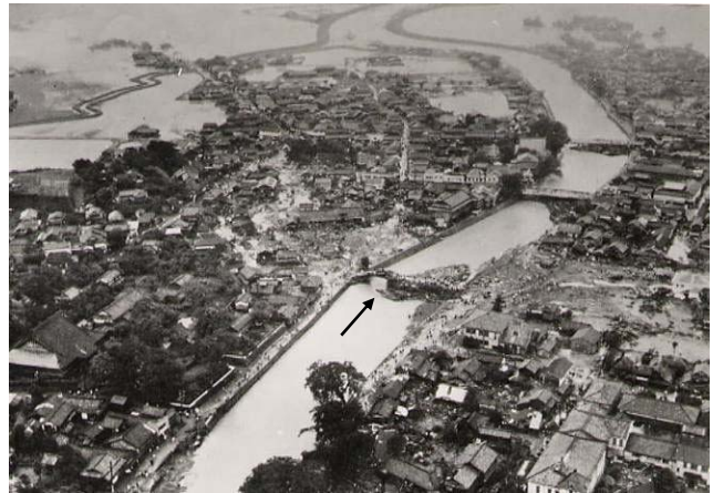
▲ 被災した諫早市街地の状況
