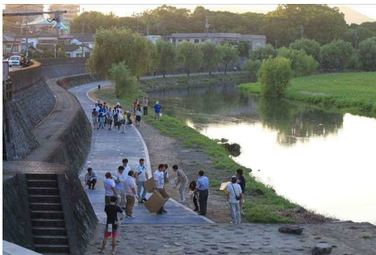
写真5-1-7 天満・永昌地区の管理用通路
