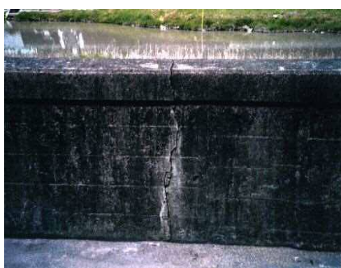
特殊堤における亀裂状況
