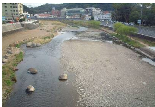
堆積土砂撤去後
