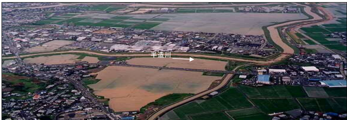
▲ 半造川周辺の浸水状況
