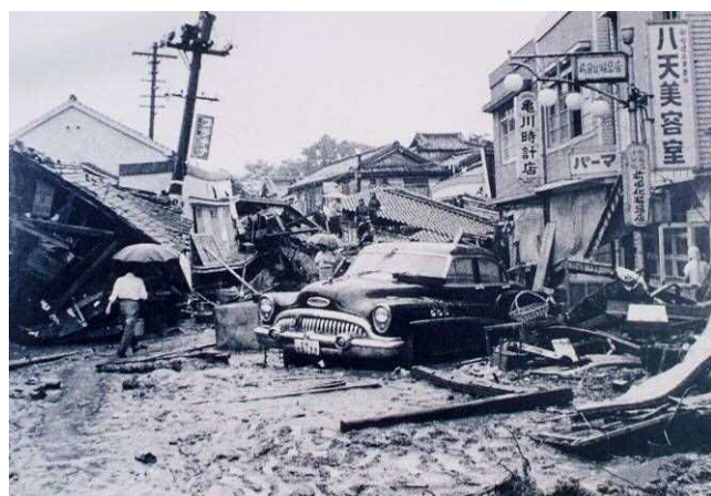
▲ 八天町の家屋倒壊の状況
