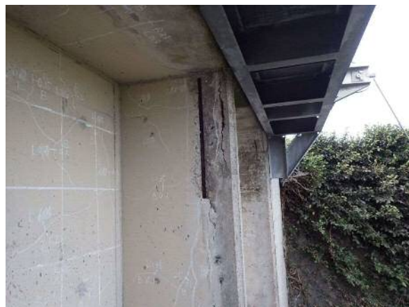
写真2-1-4 長田第5樋門の鉄筋露出
