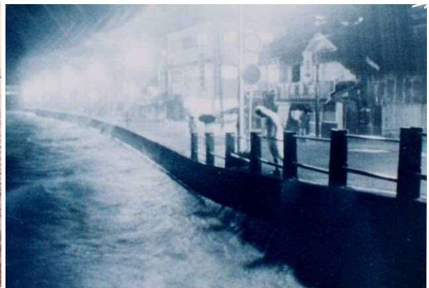
▲ 高城橋付近の洪水の状況
