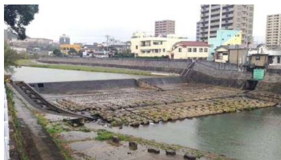
写真1-3-1 公園堰(本明川 5k000 付近)
