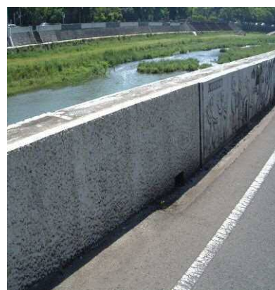
ひび割れ補強後の状況
