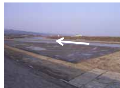
掘削直後の状況 (H18)
