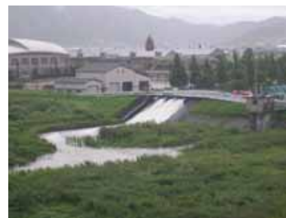
排水機場排水状況（H21.7）
