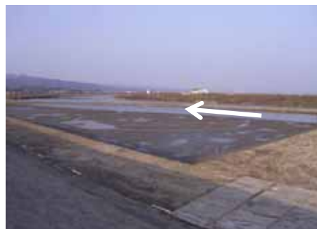
掘削直後の状況 (H18)
