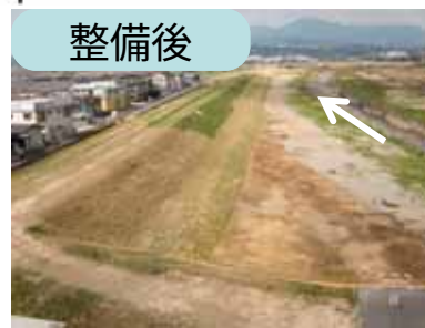
旧堤撤去後の状況
