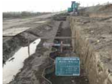
矢板設置状況
