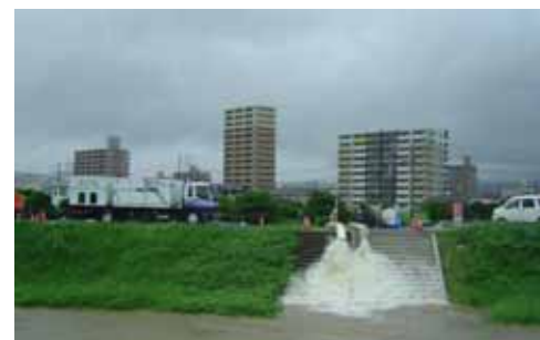
排水ポンプ車排水状況（H23.7）
