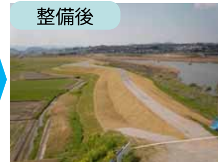
本明川下流部 堤防の拡幅・嵩上げ状況
