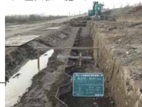
(ハット型矢板の施工)
