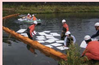
オイルフェンス、吸着マットの設置状況 (水質事故訓練にて)
