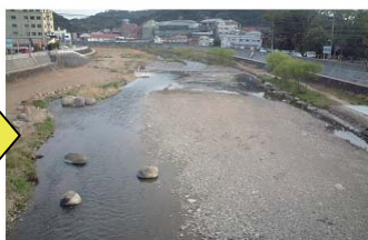
堆積土砂撤去後
