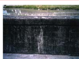
特殊堤における亀裂状況
