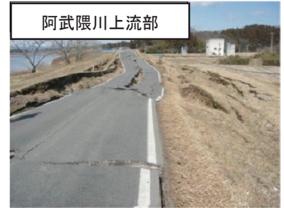
阿武隈川上流部 地震による堤防の被災状況
