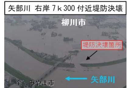
矢部川 右岸 7k300 付近堤防決壊
