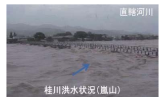
直轄河川 桂川洪水状況(嵐山) H25 台風 18 号 (9 月) 桂川 (京都市嵐山)
