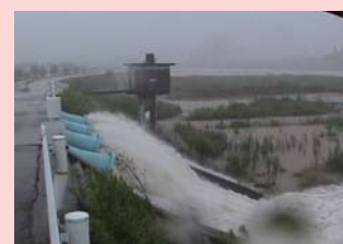
出水時におけるポンプ排水状況 (仲川救急排水機場)
