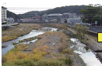
堆積土砂撤去前
