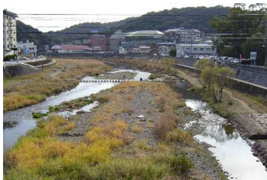
堆積土砂撤去前
