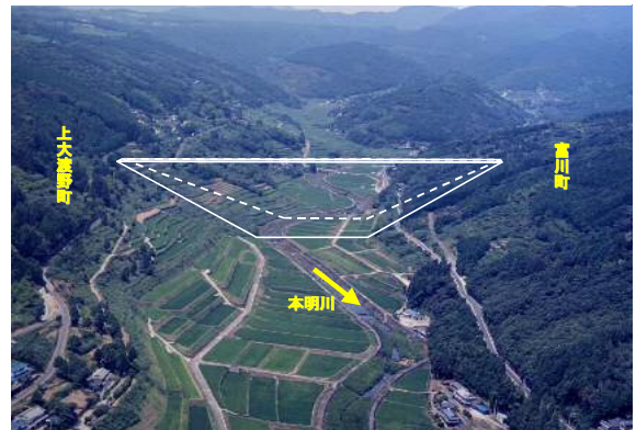
写真5-1-1 本明川ダムサイト予定地
