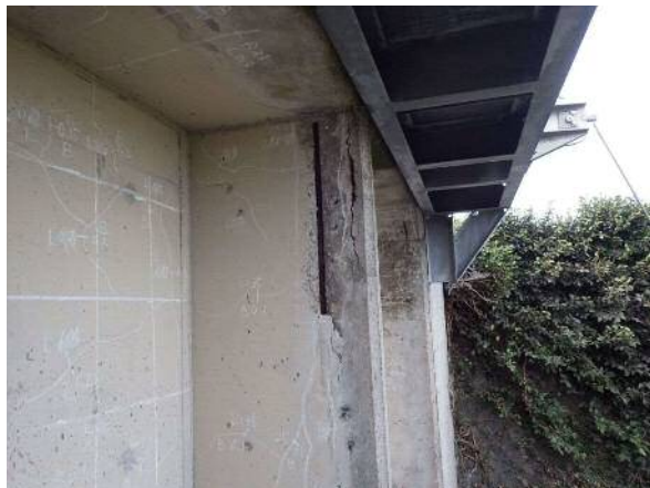
写真2-1-4 長田第5樋門の鉄筋露出
