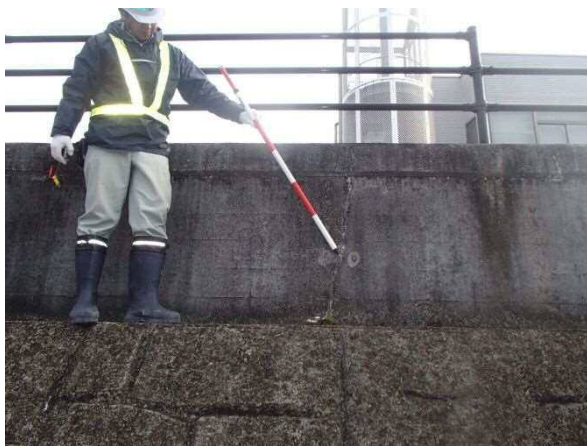
写真2-1-2 特殊堤の老朽化状況
