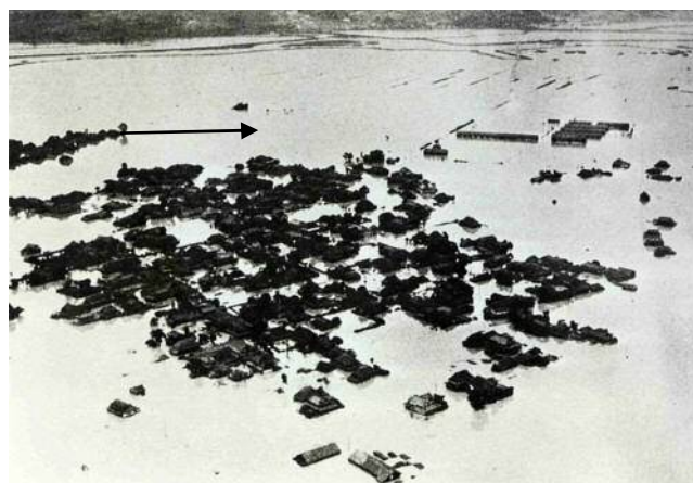
▲ 小野島地区の浸水状況
