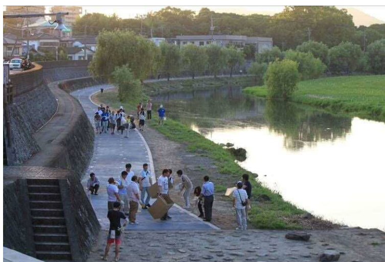
写真5-1-7 天満・永昌地区の管理用通路
