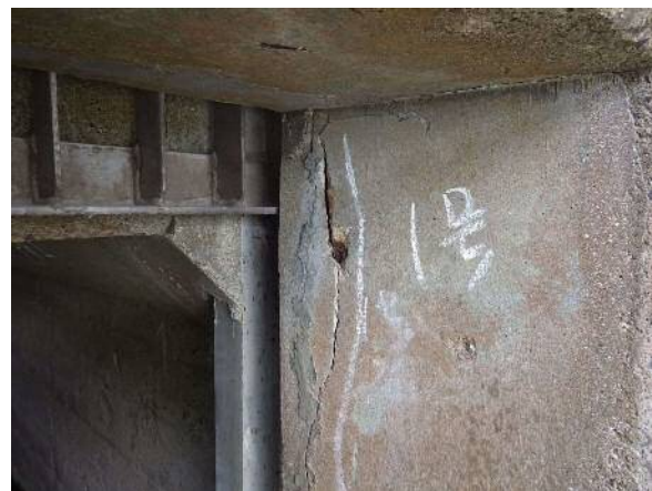
写真2-1-3 長田第1樋門のクラック
