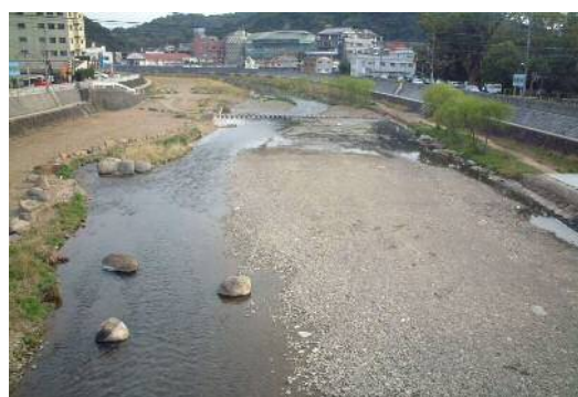
堆積土砂撤去後
