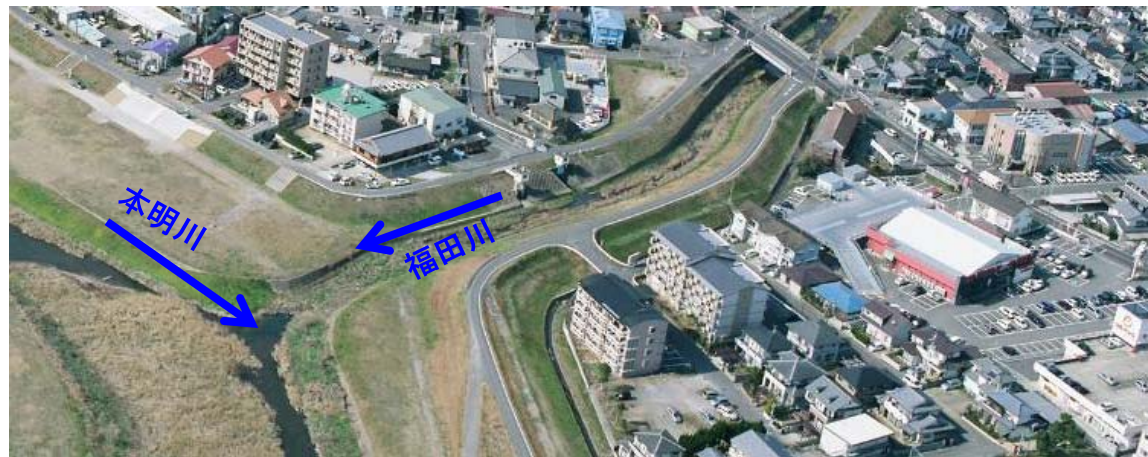
合流点の河川敷が分断され、歩行できない(不連続箇所)
