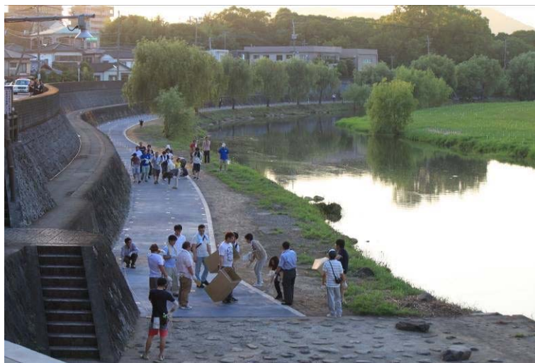
写真5-1-7 天満・永昌地区の管理用通路
