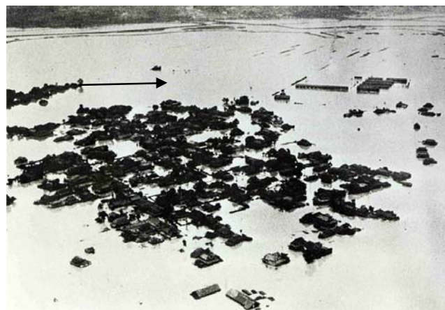
▲ 小野島地区の浸水状況
