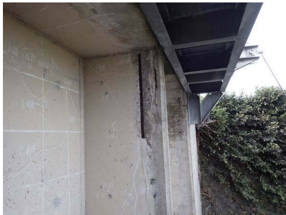
写真2-1-4 長田第5樋門の鉄筋
