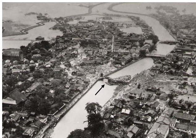
▲ 被災した諫早市街地の状況
