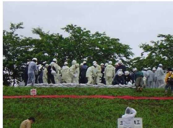
写真5-2-10 水防工法の訓練状況
