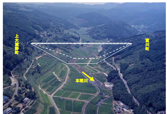
写真5-1-1 本明川ダムサイト予定地
