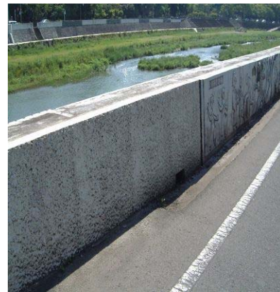
ひび割れ補強後の状況
