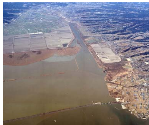
④河口部 諫早湾干拓事業により新たに調節池や広大な自然干陸地が出現しました。
