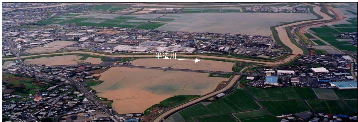
▲ 半造川周辺の浸水状況
