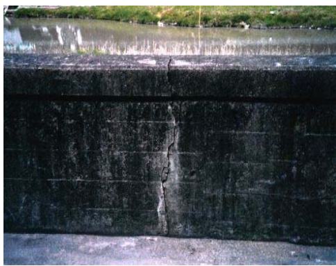
特殊堤における亀裂状況
