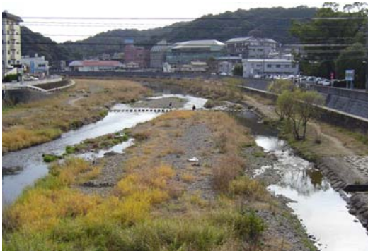
堆積土砂撤去前
