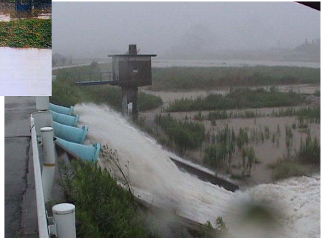
写真5-2-4 出水時におけるポンプ排水状況(仲沖救急排水機場)
