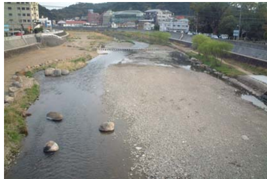
堆積土砂撤去後
