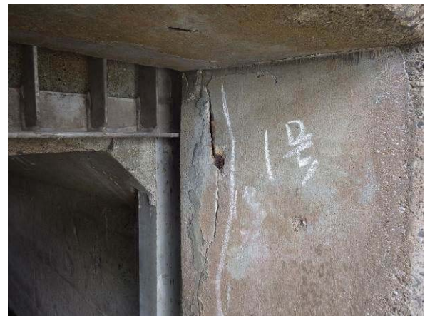
写真2-1-3 長田第1樋門のクラック
