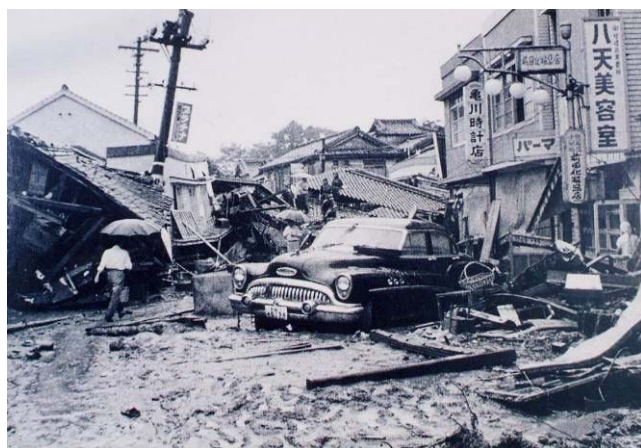
▲ 八天町の家屋倒壊の状況
