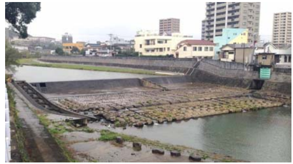
写真1-3-1 公園堰(本明川 5k000 付近)
