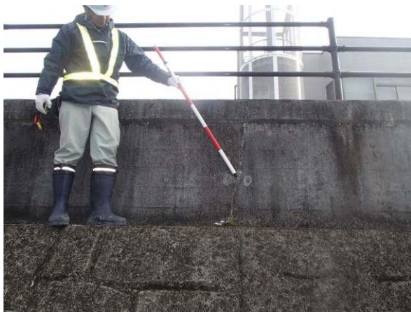
写真2-1-2 特殊堤の老朽化状況
