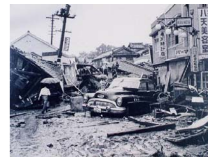
昭和32年7月洪水(八天町付近)
