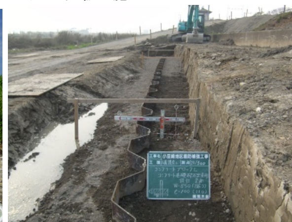
ハット型矢板の施工
