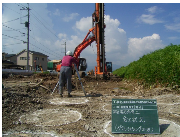
新技術による施工(地盤改良工)
