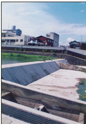
平成6年渇水時の公園堰下流
