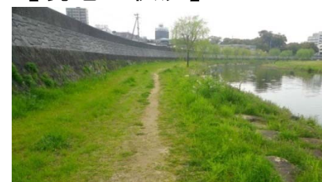
整備されていない管理用通路
