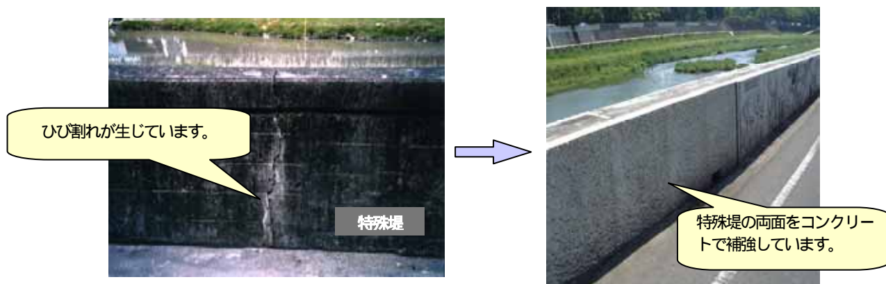
写真4 - 3 - 1 特殊堤の監視と強化対策
