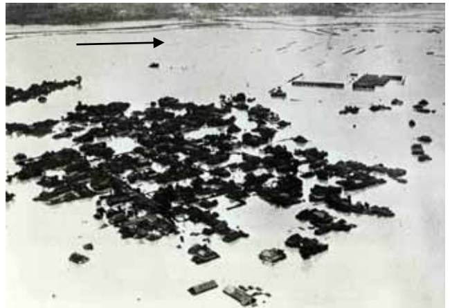
小野島地区の浸水状況
