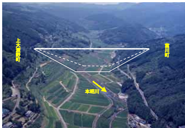
図4 - 2 - 18 本明川ダムサイト予定地
