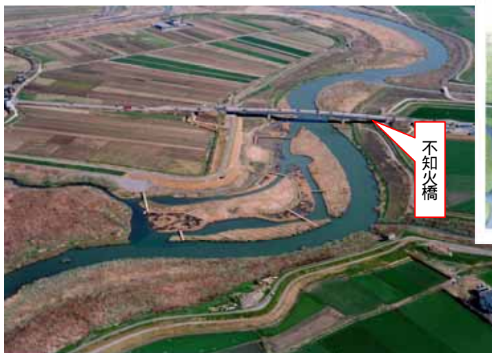
ヨシ原再生事業(本明川左岸 1k000 付近)
