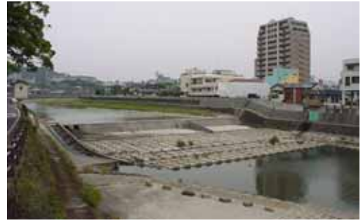
写真1-3-1 公園堰(本明川 5k000 付近)
