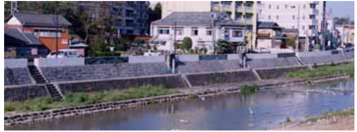
写真2-1-1 中流部の河川管理施設 (特殊堤・樋門・陸閘)
