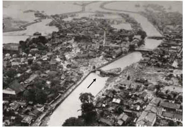
被災した諫早市街地の状況
