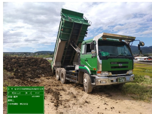
現地発生材の再利用（土砂運搬状況）
