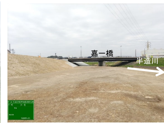
嘉一橋下流の引堤事業後
