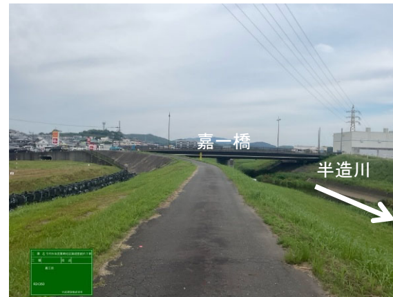
嘉一橋下流の引堤事業前
