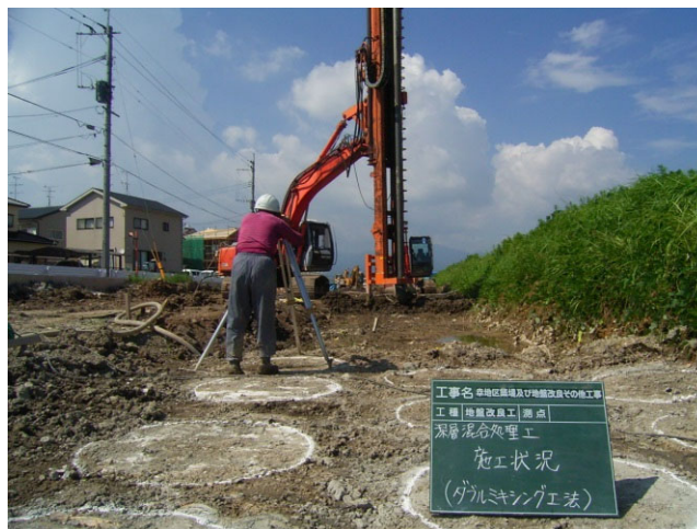
新技術による施工（地盤改良工）
