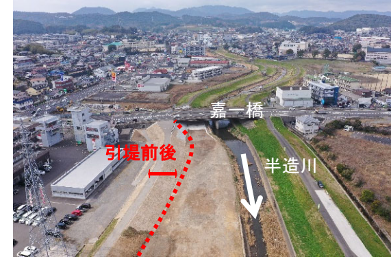
嘉一橋下流の引堤事業後
