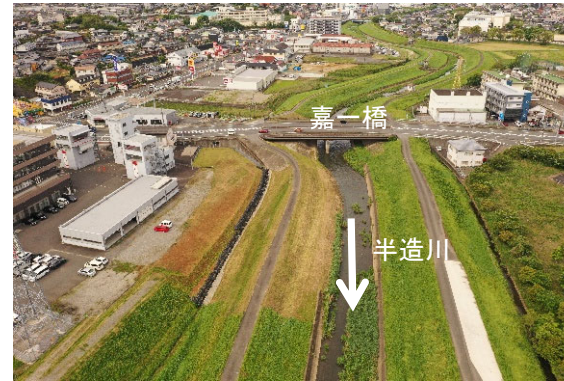
嘉一橋下流の引堤事業前
