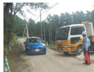
交通誘導員配置状況
