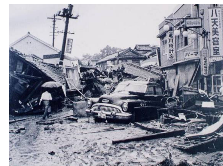
昭和32年7月洪水(八天町付近)
