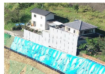
防音シートの設置状況
