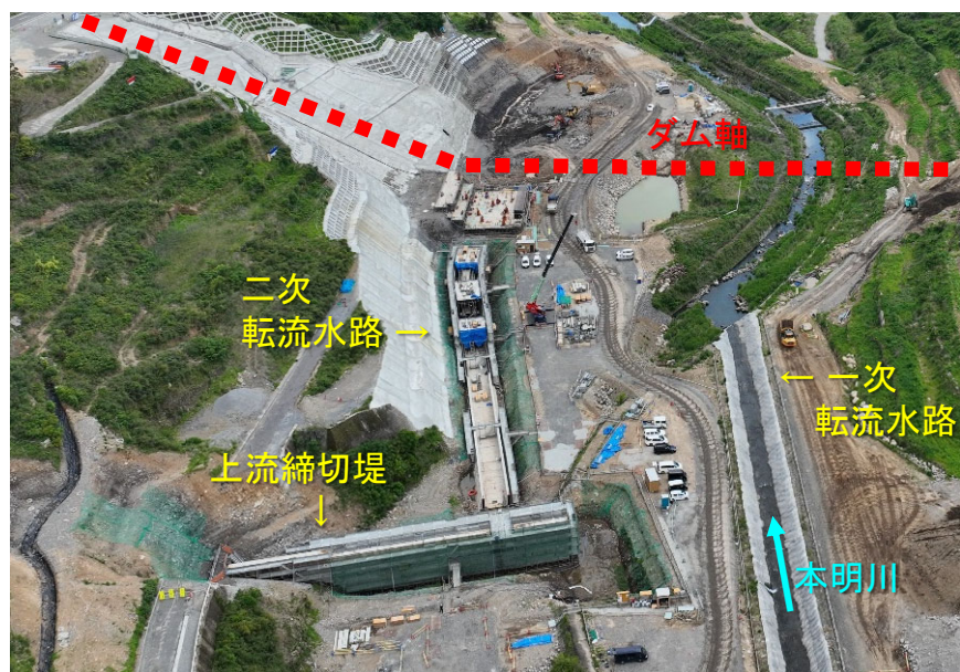
二次転流工施工状況_R8.5月時点
