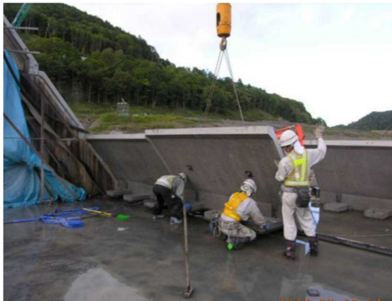
プレキャスト型枠 高さ1.5m×幅3.0m
