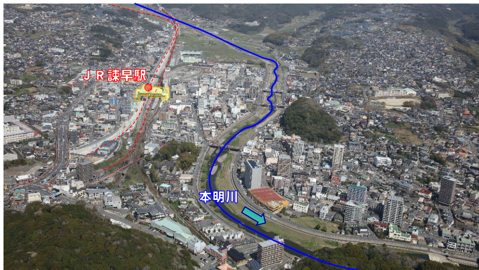
本明川中流部の状況写真（令和3年3月撮影）
