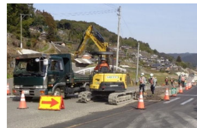
アスファルト舗装の撤去状況
