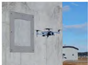
ドローンによる損傷把握
