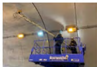
レーザを利用した トンネル覆工の変状把握
