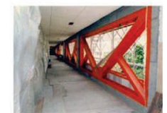
鉄骨ブレースによる壁の補強
