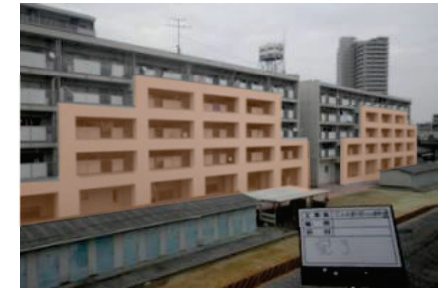
▲外付けフレーム耐震補強
