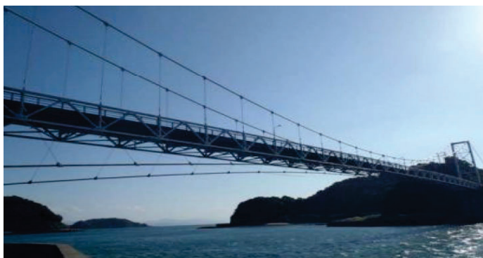
▲樋島大橋全景写真
