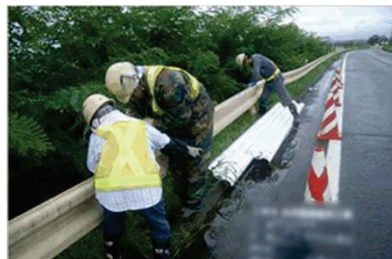
<防護柵の取替>
