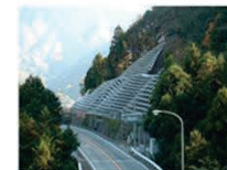
斜面崩落防止対策
