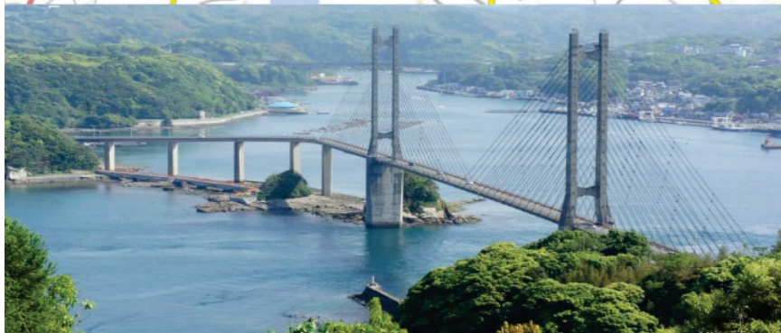
▲呼子大橋全景写真
