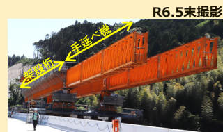
写真7 手延べ機、架設桁
