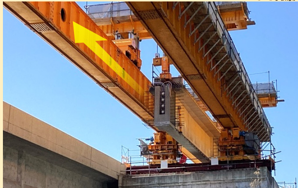
写真6 架設桁架設工法
