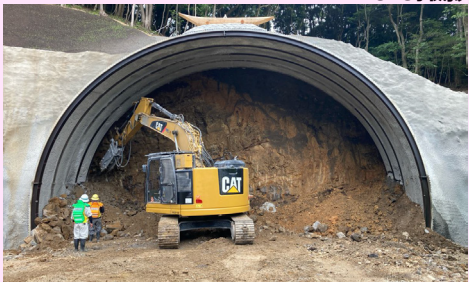
写真10 トンネル掘削の様子
