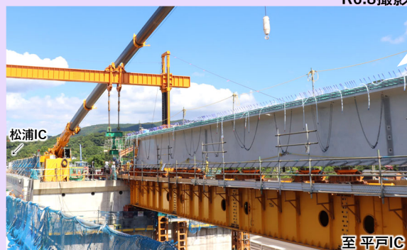
橋げた架設の様子
