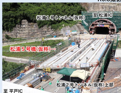
※松浦2号トンネル(仮称)上部より撮影
