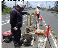
(貫入試験による調査)
