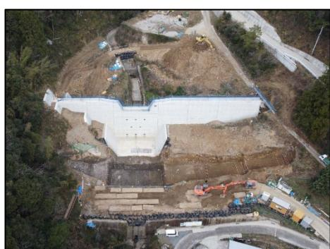
治山施設の整備による土砂流出抑制(県)
