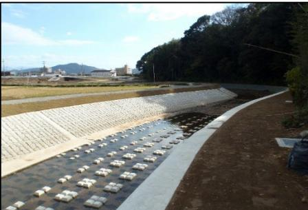
砂防施設の整備による土砂流出抑制(県)
