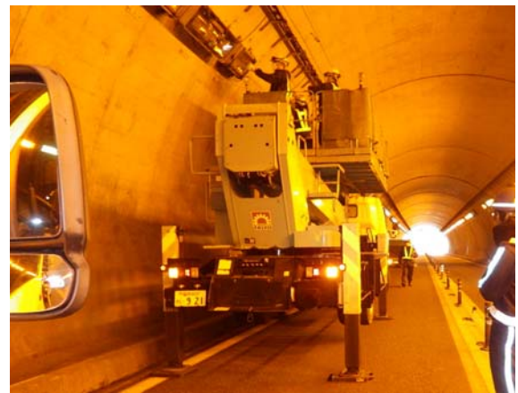
<トンネル照明灯具取替工事>
