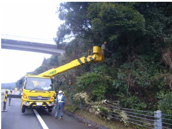
<樹木伐採作業>
