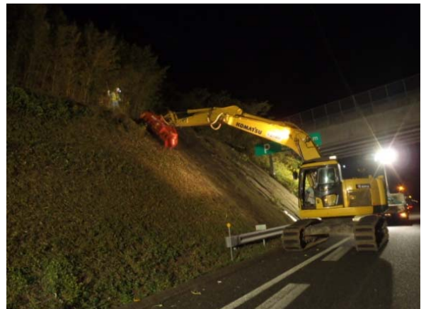
<切土のり面伐採作業>
