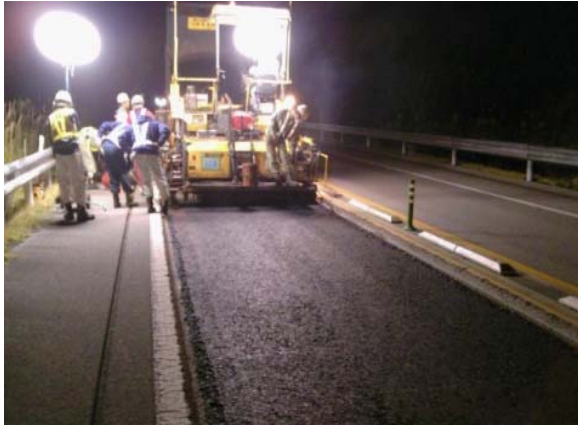
<舗装補修工事>
