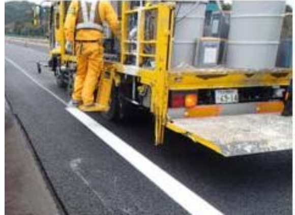
<路面標示工事>
