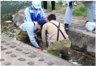
【土のう積み訓練の状況】
