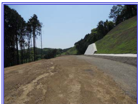
工事現場箇所
