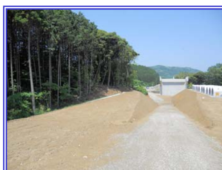
工事現場箇所
