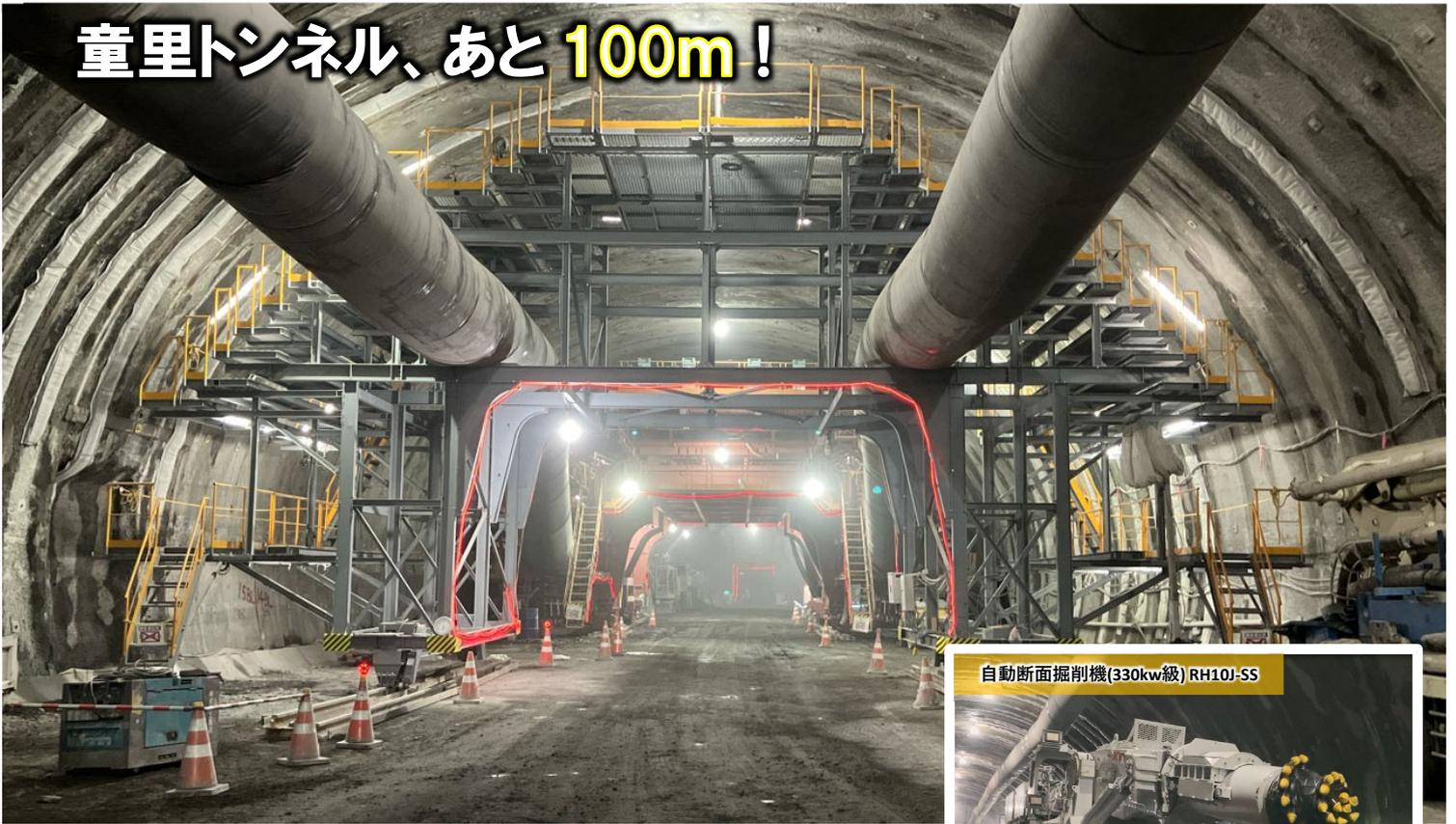
令和6年10月4日時点で掘削は全491m中、391mまで進み、あと100mとなりました。現在は、トンネル内面をコンクリートで覆うための型枠が設置されています。今後も安全第一に工事を進めていきます。
