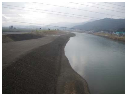
拠点水際の緩傾斜化(掘削)
