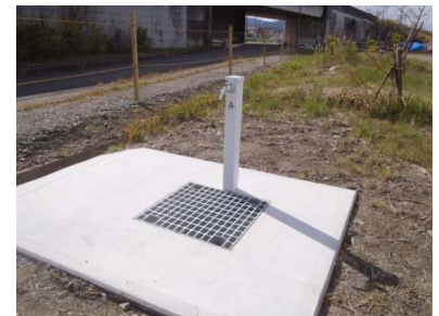
延岡市が設置した水道設備
