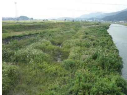
五ヶ瀬大橋上流(掘削前の状況)
