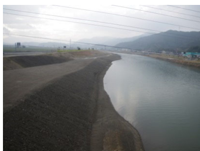
拠点水際の緩傾斜化（掘削）
