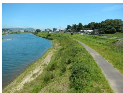
散策路整備状況（五ヶ瀬大橋付近）
