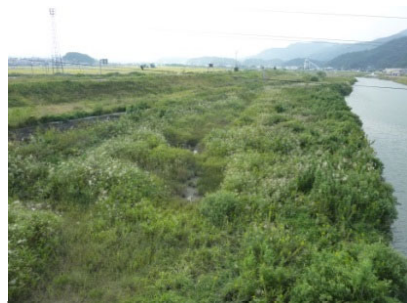
五ヶ瀬大橋上流（掘削前の状況）
