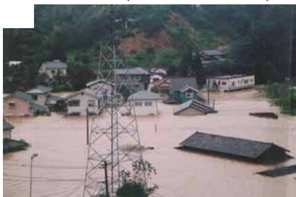
岡富町付近 (五ヶ瀬川 3 k 000 左岸)
