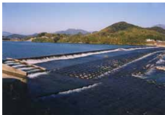
写真 1-3-1 岩熊井堰（五ヶ瀬川 11K000 付近） 岩熊井堰は五ヶ瀬川の農業用水利用の中で大規模かつ重要な取水施設となっています。
