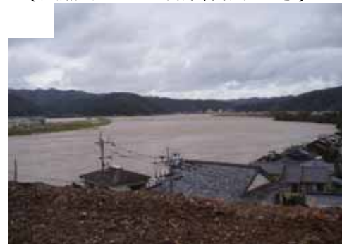
川島橋下流 （北川 3 k 800, 台風 23 号）
