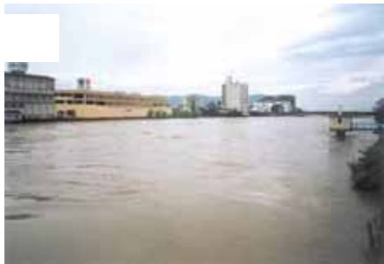
北小路町付近 (五ヶ瀬川 3k 500 左岸)
