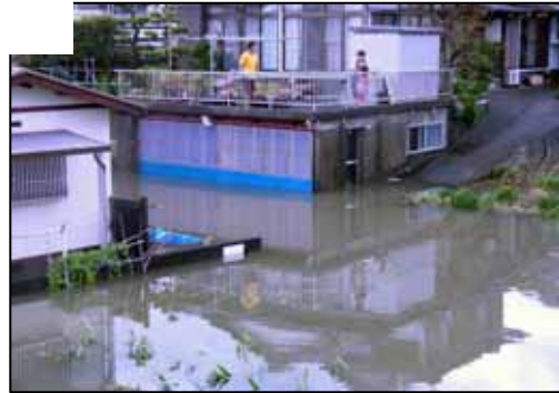
岡富町地区 （五ヶ瀬川 4 k 400 左岸付近, 台風 16 号）
