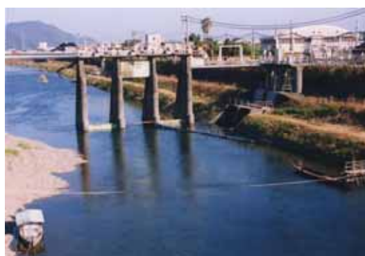
写真 1-3-3 旭化成取水口（大瀬川 3K200 付近）
