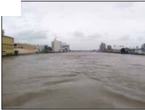
亀井橋下流 （五ヶ瀬川 3 k 800, 台風 16 号）
