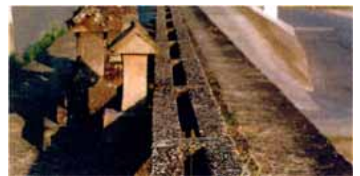
写真 1-2-1 畳堤(畳をはめこむコンクリート製の枠)と 水害水難防止を祈願する水神様
