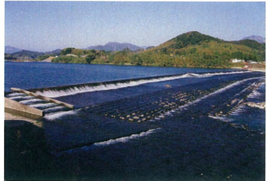
写真 1-3-1 岩熊井堰(五ヶ瀬川 11K000 付近)
