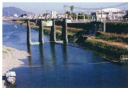
写真 1-3-3 工業用水取水口（大瀬川 3K200 付近）
