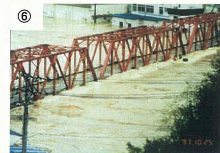
⑥ 北川町 熊田橋付近
