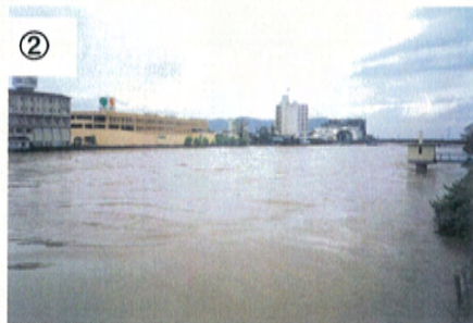
② 北小路町付近 (五ヶ瀬川 3k 500 左岸)
