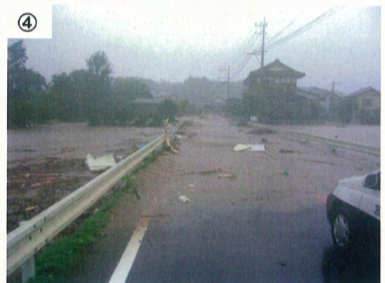
④ 小峰地区 (五ヶ瀬川 6k 900 左岸)
