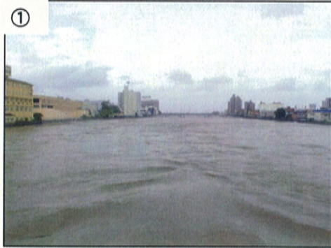
① 亀井橋下流 (五ヶ瀬川 3 k 800, 台風 16 号)
