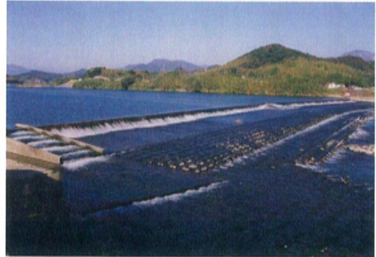
写真 1-3-1 岩熊井堰(五ヶ瀬川 11K000 付近)
