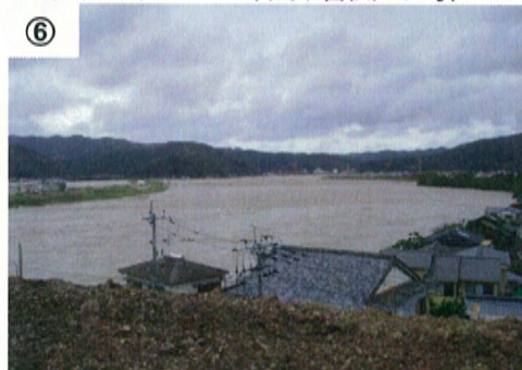
⑥ 川島橋下流 (北川 3 k 800, 台風 23 号)
