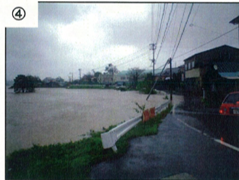
④ 大瀬大橋下流 (大瀬川 5 k 200 右岸, 台風 16 号)
