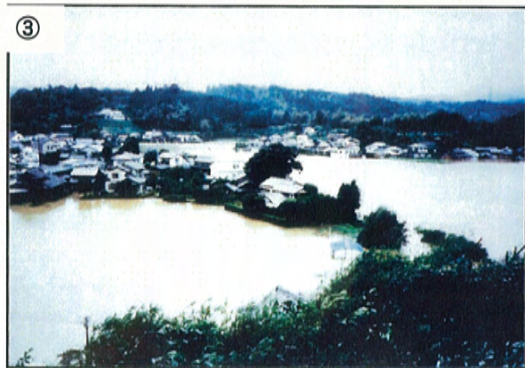
③ 小峰地区 (五ヶ瀬川 7k000 左岸)
