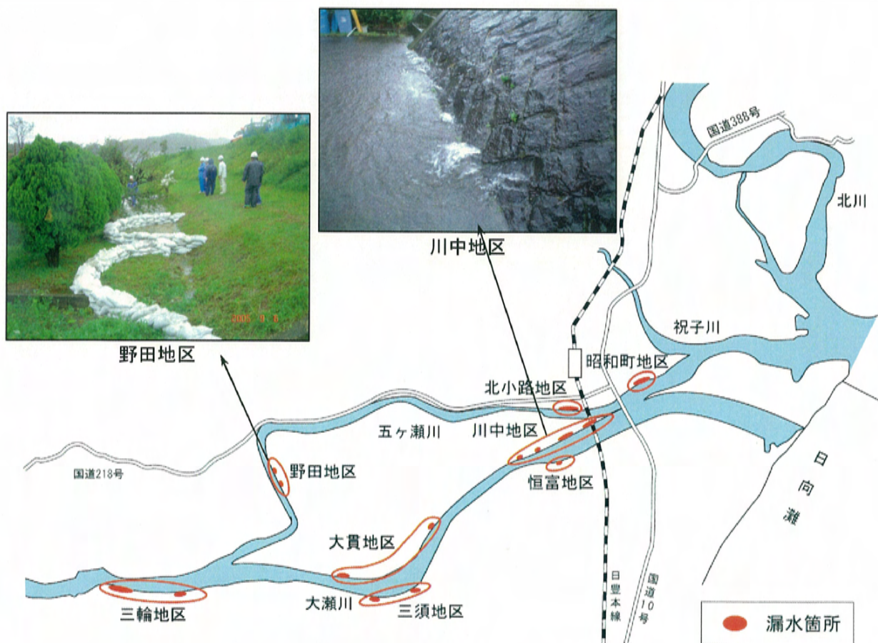
図 2-1-5 平成 17 年 9 月洪水時の漏水の状況
