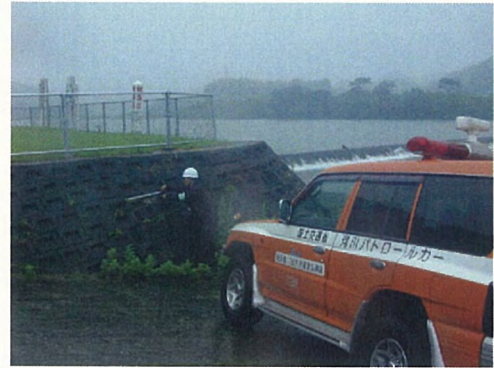
写真 4-3-2 河川巡視状況
