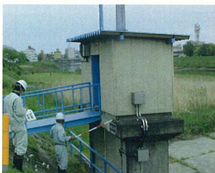
写真 4-3-1 水門の保守点検
