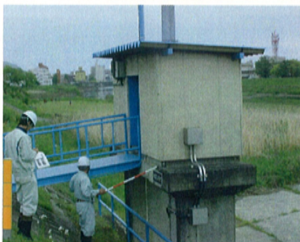
写真 4-3-1 水門の保守点検
